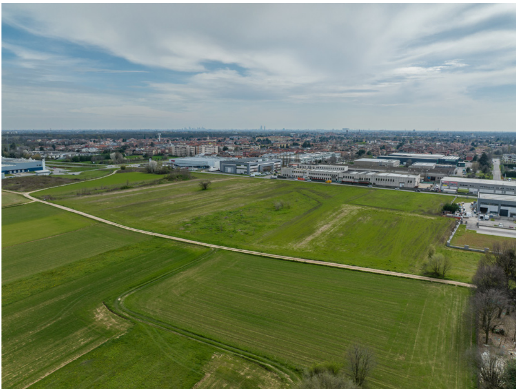
Area di intervento, lato nord
