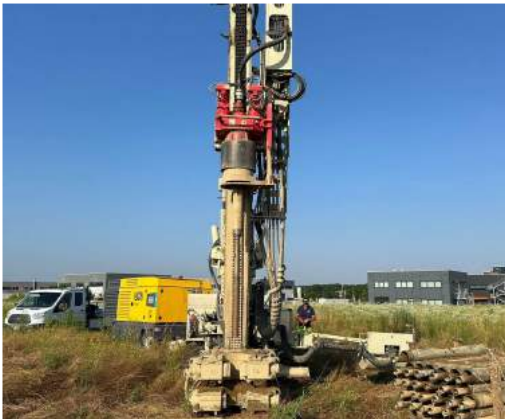
Fig. 2.1 – Trivella cingolata COMACCHIO MC15 utilizzata per l'esecuzione delle trivellazioni
