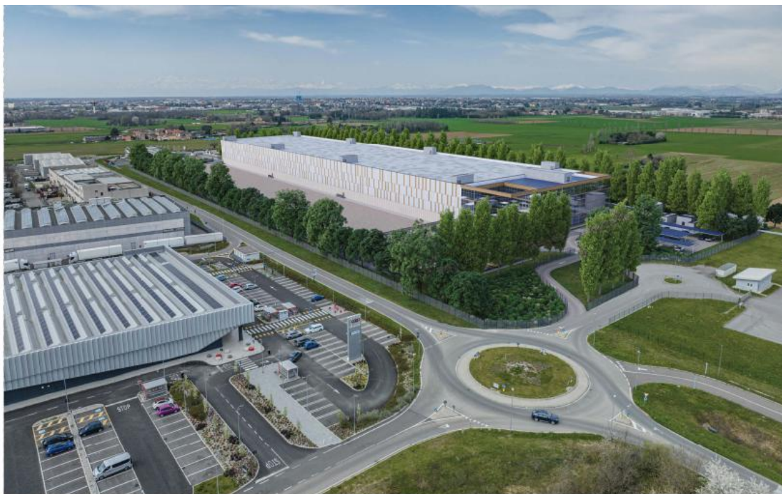
vista aerea da sud-est
