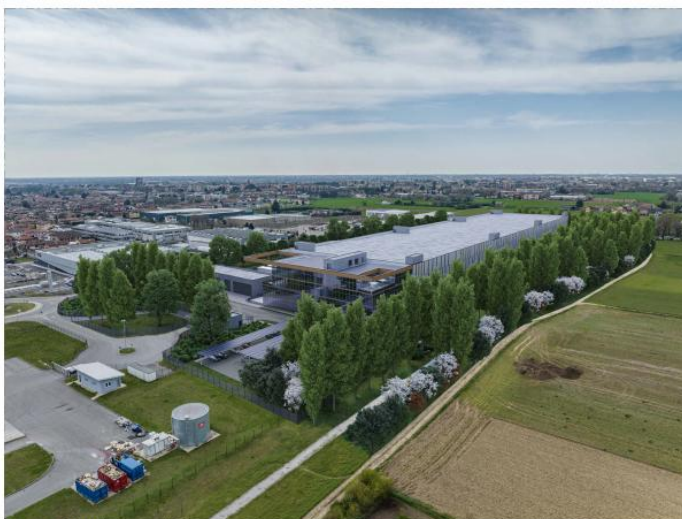
vista aerea da nord-est
