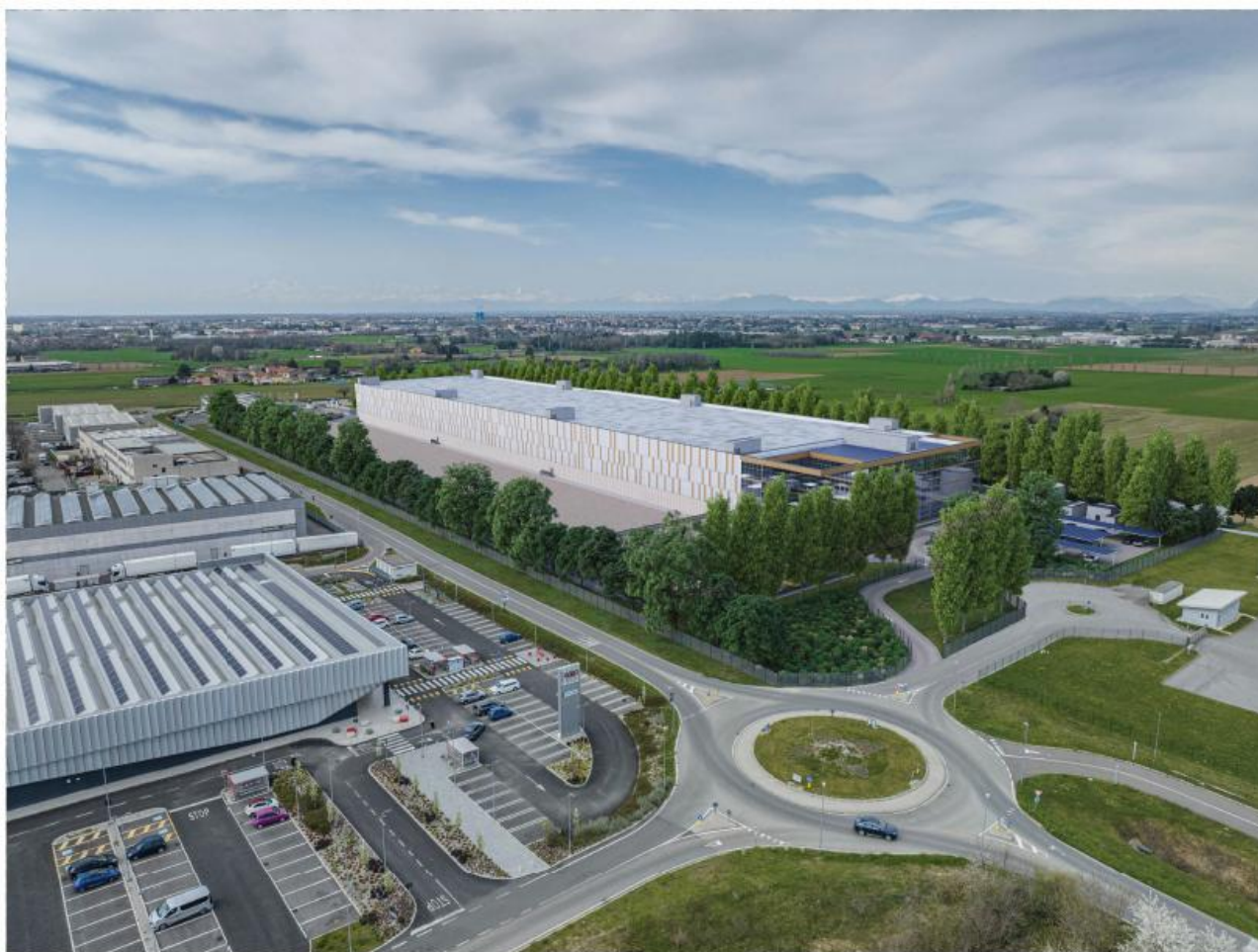
vista aerea da sud-est
