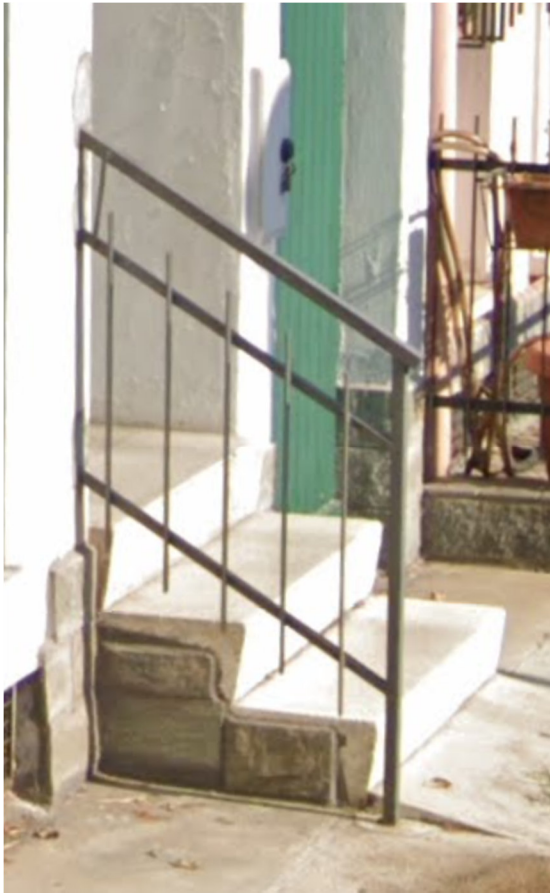
Parapetti e gradini ingressi
