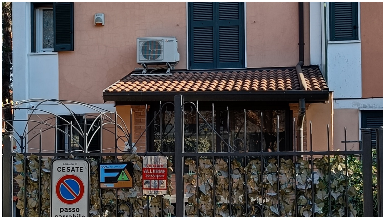
Particolare tettoia ampliamento unità 1 riferimento da tenere per la profondità
