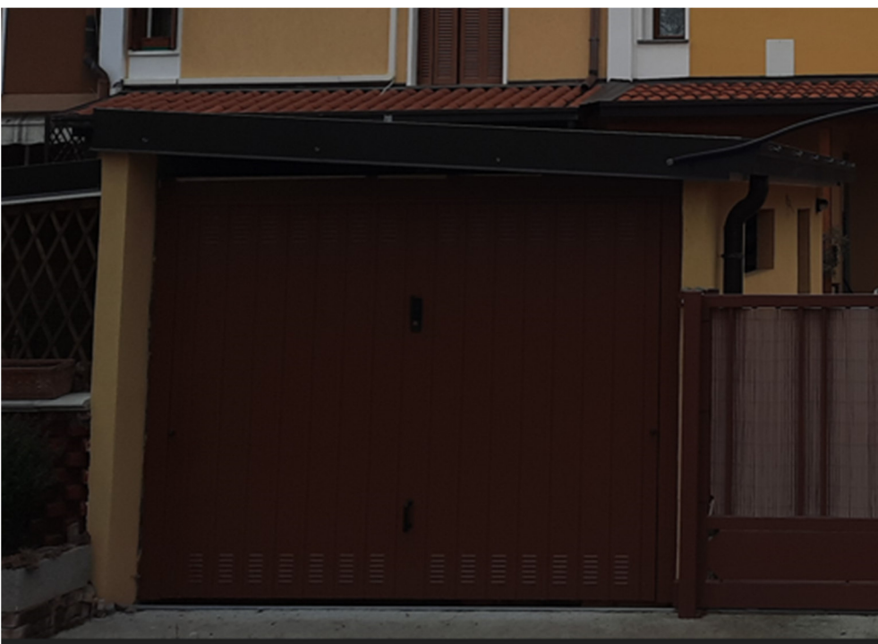
Particolare vista box e finiture
