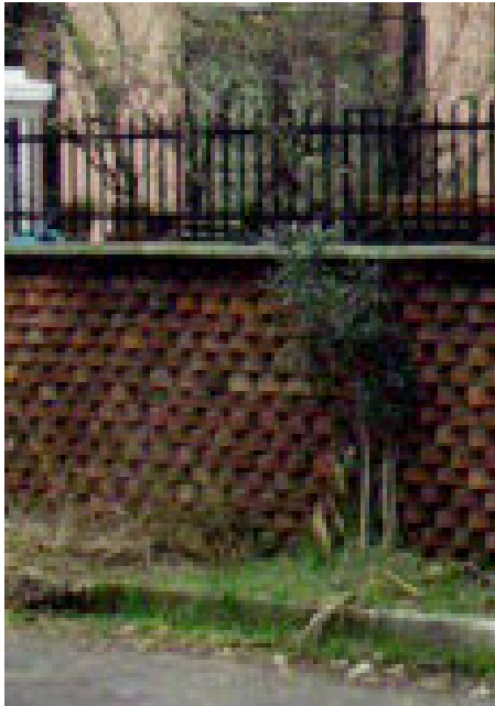
Particolare recinzione sul retro
