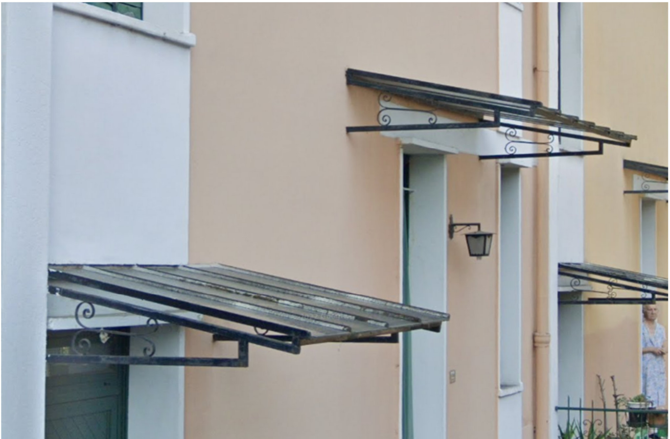
Particolare tettoie ingressi fronte principale
