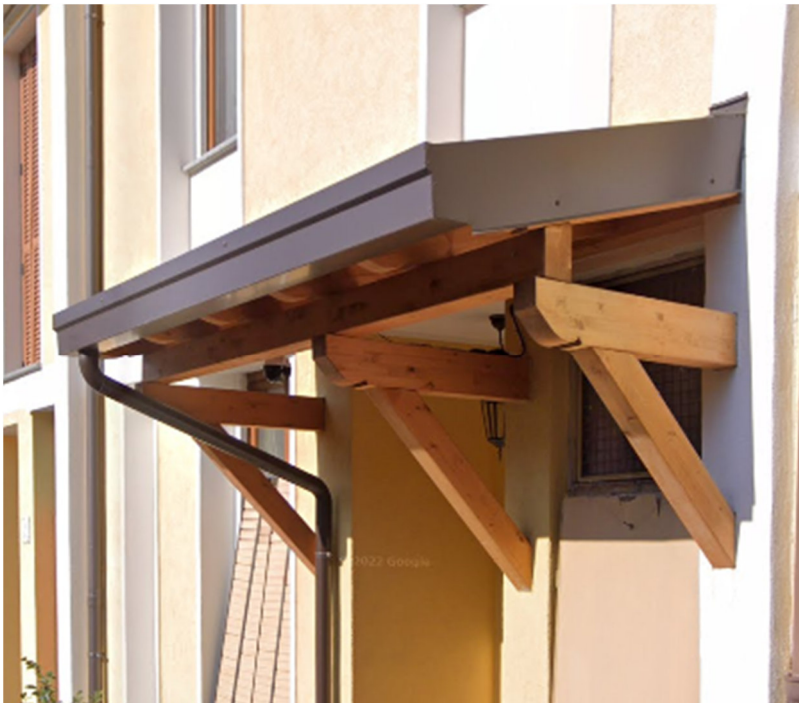
Particolare tettoie su ingressi
