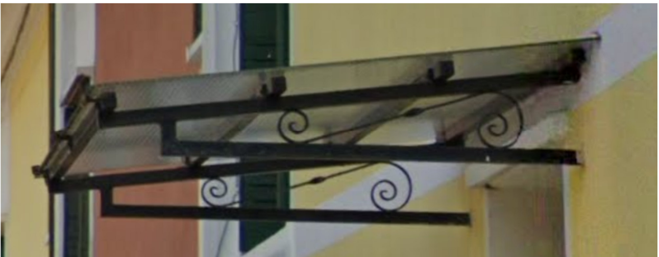
Tettoia su fronte principale
