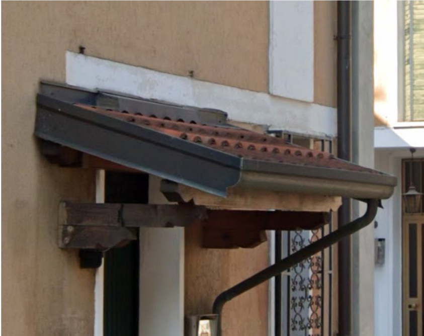
Particolare tettoie ingressi fronte principale
