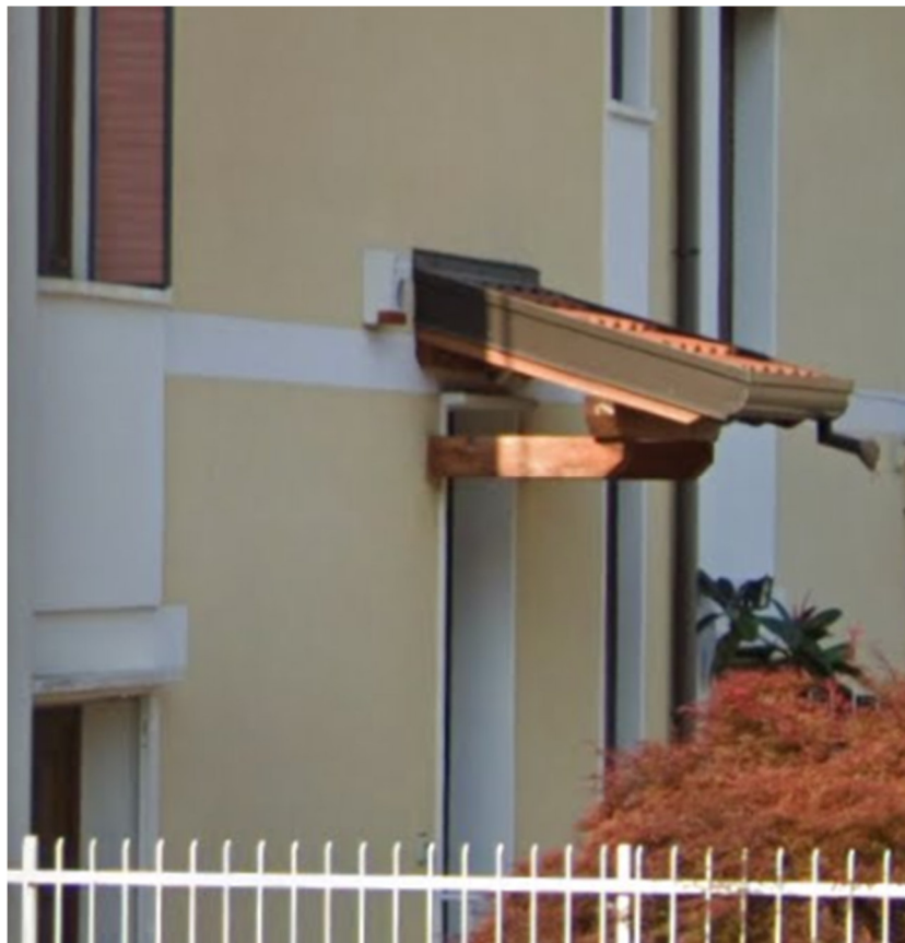
Particolare tettoie ingressi fronte principale
