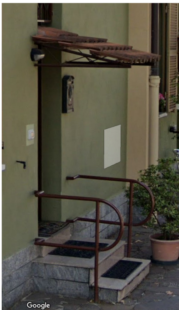
Particolare tettoia ingresso e ringhiera sagomata
