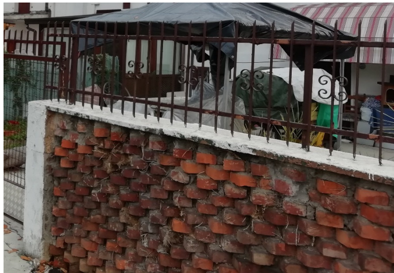
Recinzioni in mattoni (h 1,20 m), posati con spigolo vivo a vista, con sovrastante ringhiera in ferro/alluminio marrone RAL 8017 (h 0,35 m) totale altezza 1,55 m
