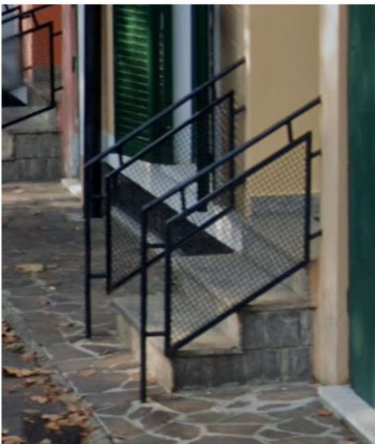
Particolare ringhiera gradini e rivestimento gradini e pavimentazione esterna
