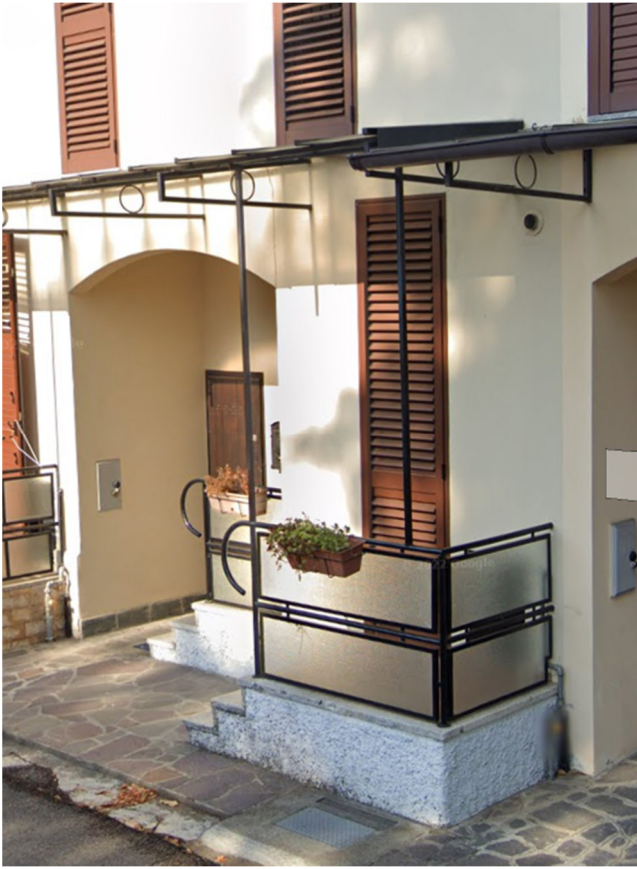
Particolare tettoia ingresso e ringhiera gradini accessi fronte principale.
