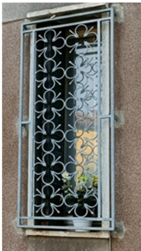
Particolare disegno grate da realizzarsi in color verde RAL 6005
