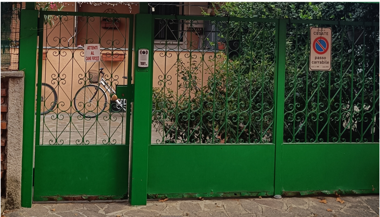
Stile cancello sul retro senza copertura
