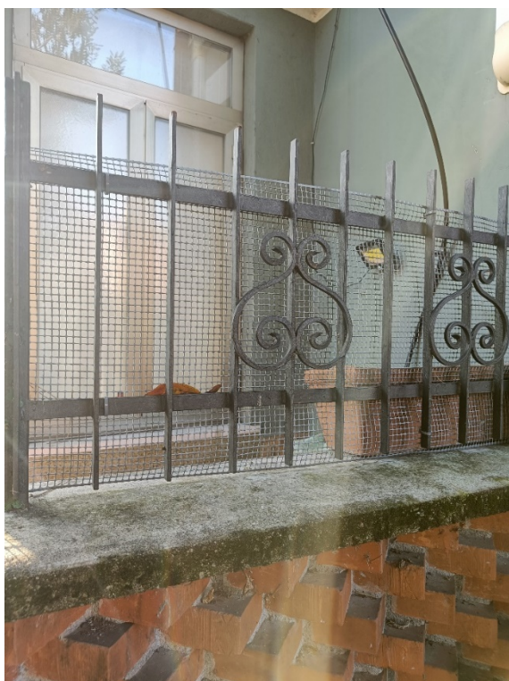
Particolare recinzione retro e tra unità.
