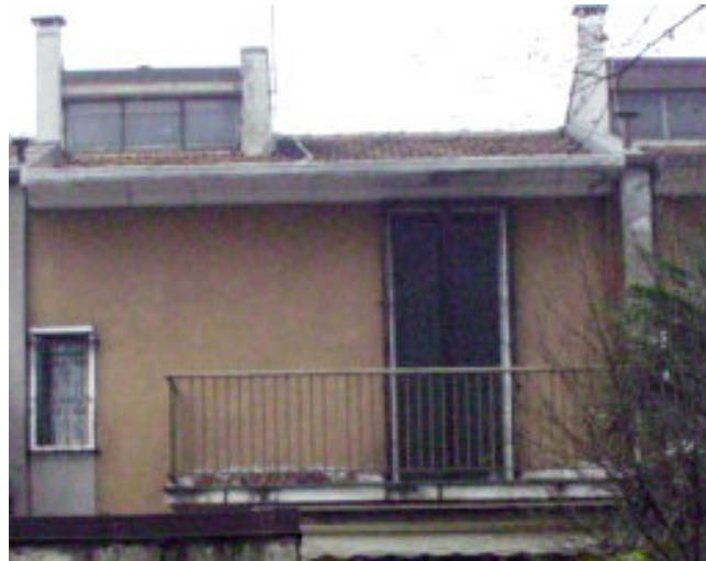
Particolare balconi su veranda
