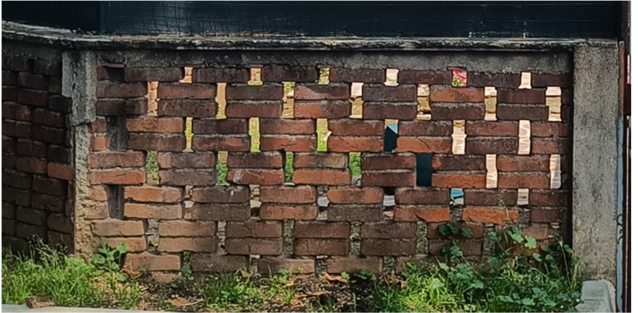
Tipologia posa mattoni recinzione sul retro
