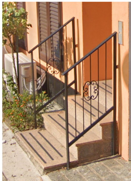
Particolare gradini ingresso e ringhiera
