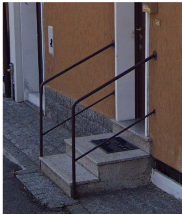
Dettaglio ringhiera gradini
