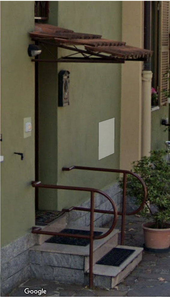
Particolare tettoia ingresso e ringhiera sagomata
