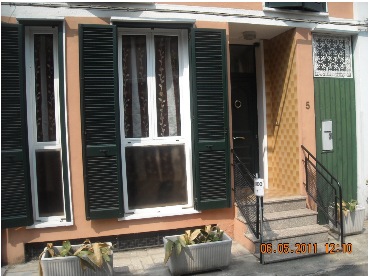
Particolare serramenti e grate
