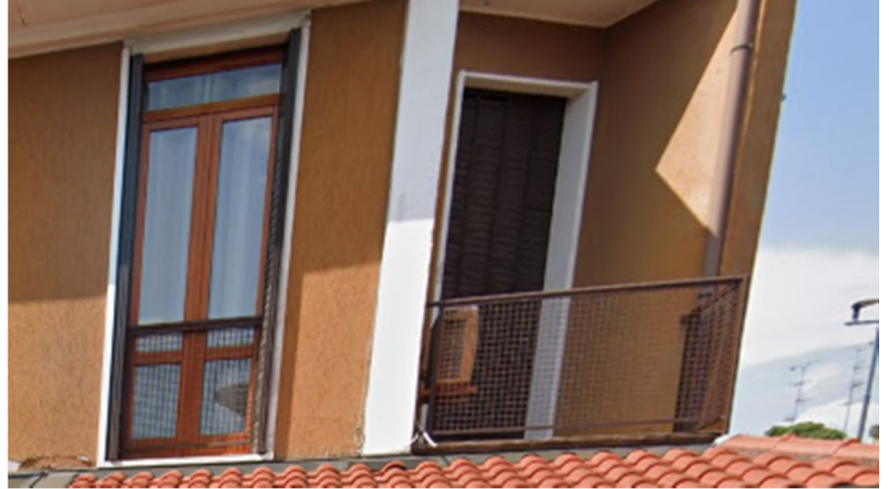
Particolare ringhiere porte finestre
